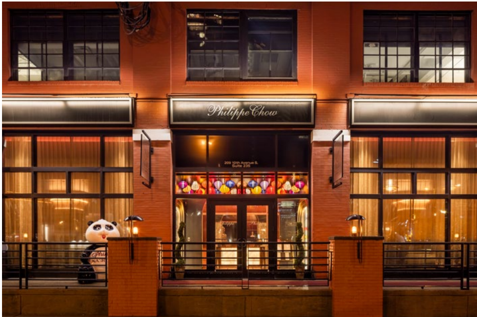
MIAN ENTRANCE EXTERIOR
